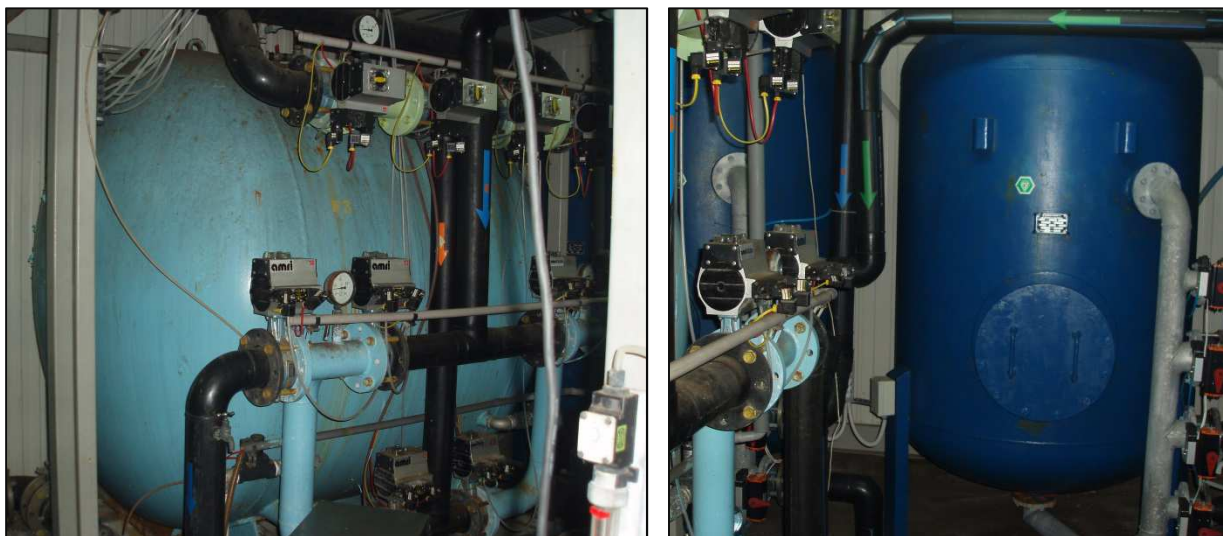
Fot. 1 - 2 Filtry odżelaziająco - odmanganiające poziome i pionowe
